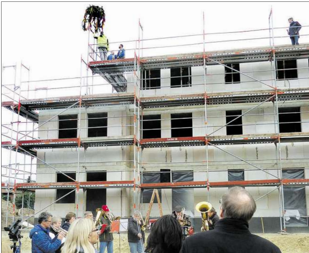
Richtfest an der Friedensstraße: Hier entstehen zwei Wohnhäuser für Menschen mit Beeinträchtigungen, gebaut von der Diakonie Himmelsthür.
