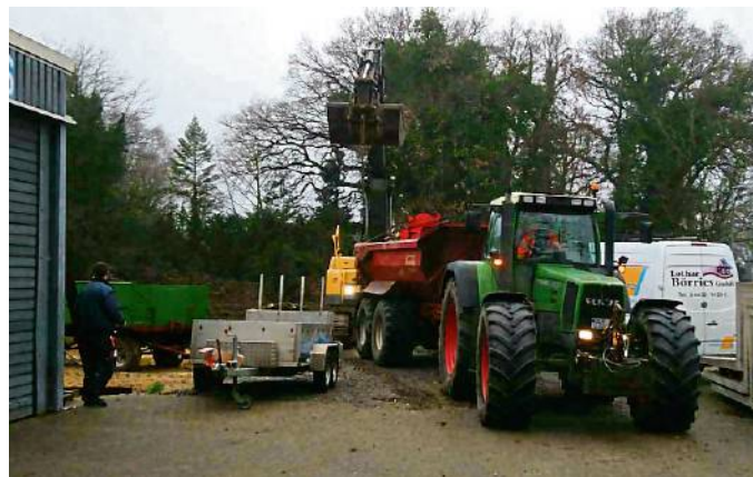
Trecker und Bagger beim THW in Bookholzberg: Jetzt soll es mit dem Neubau zügig weitergehen.
